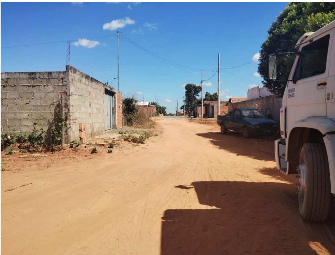
FOTO N° 17: IMAGEM DA RUA A SER PAVIMENTADA
