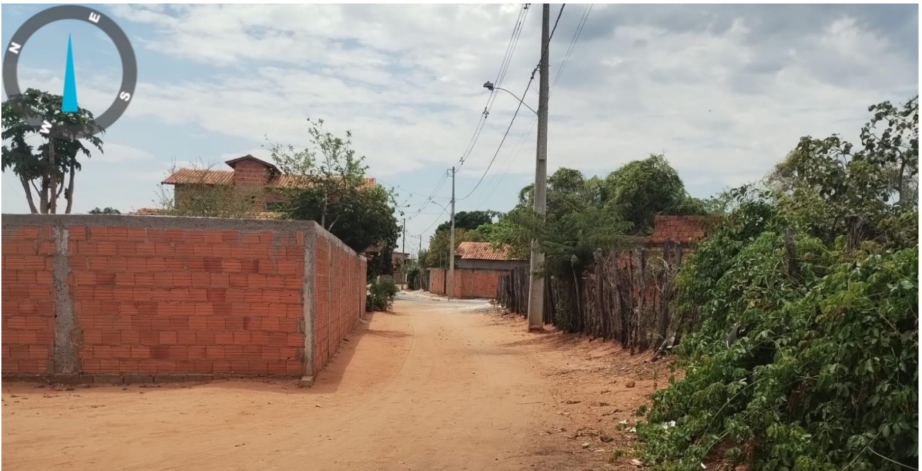
FOTO N° 15: IMAGEM DA RUA A SER PAVIMENTADA
